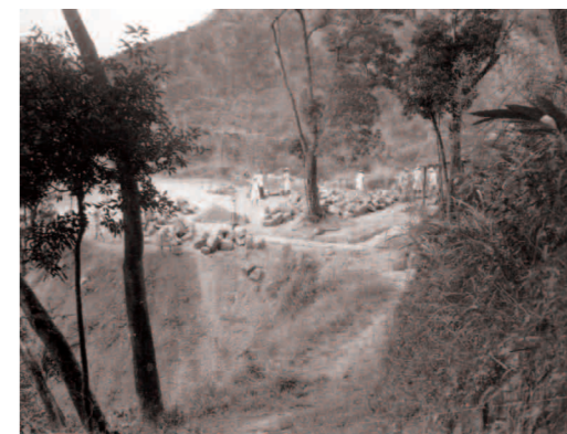
開拓環山道路及擴建停車場
